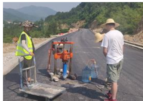
路面完工后及时试验检测
