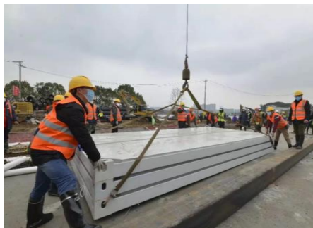
杜辉煌在火神山指挥施工
